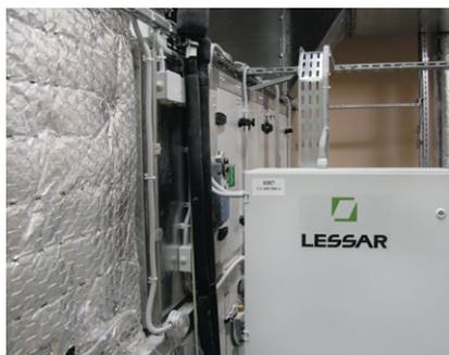
Контроллер фреоновых секций приточных установок LZ-AHU позволяет подключить фреоновую секцию приточной вентустановки к наружному блоку мультизональной системы LMV. Контроллер позволяет работать с одноконтурной системой до 56 кВт и с двухконтурной системой до 90 кВт.
